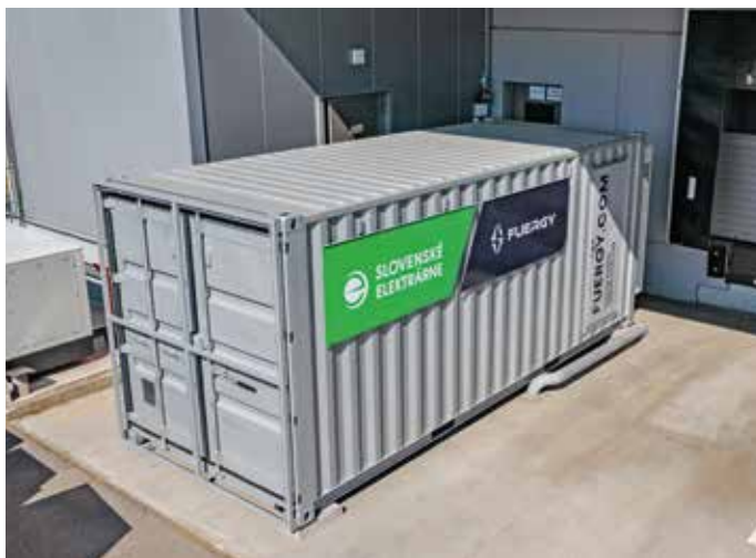
Smart batériové úložisko brAln by FUERGY v textilnom závode v Humennom
