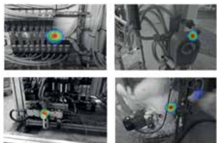
Ukázka nalezeného úniku stlačeného vzduchu
