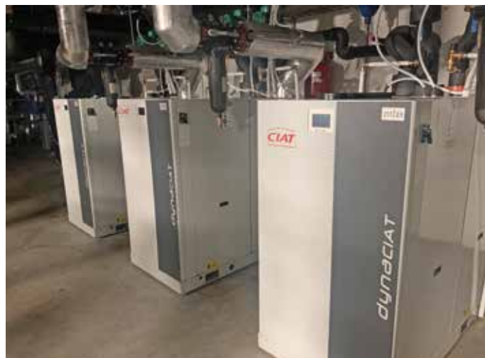
Tepelné čerpadlá regulované v areáli Národného futbalového štadióna
